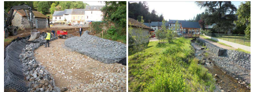
La remise à ciel ouvert d'une portion du ruisseau de Cubes, à Châteauneuf-les-Bains, dans le Puy-de-Dôme. Source : zoneshumides.org
